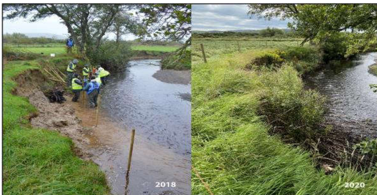
Sampla de bhainistiú dríodair ar Abhainn Glenagannon , Inis Eoghain, (Foinse: Iontaobhas Aibhneacha Inis Eoghain)
